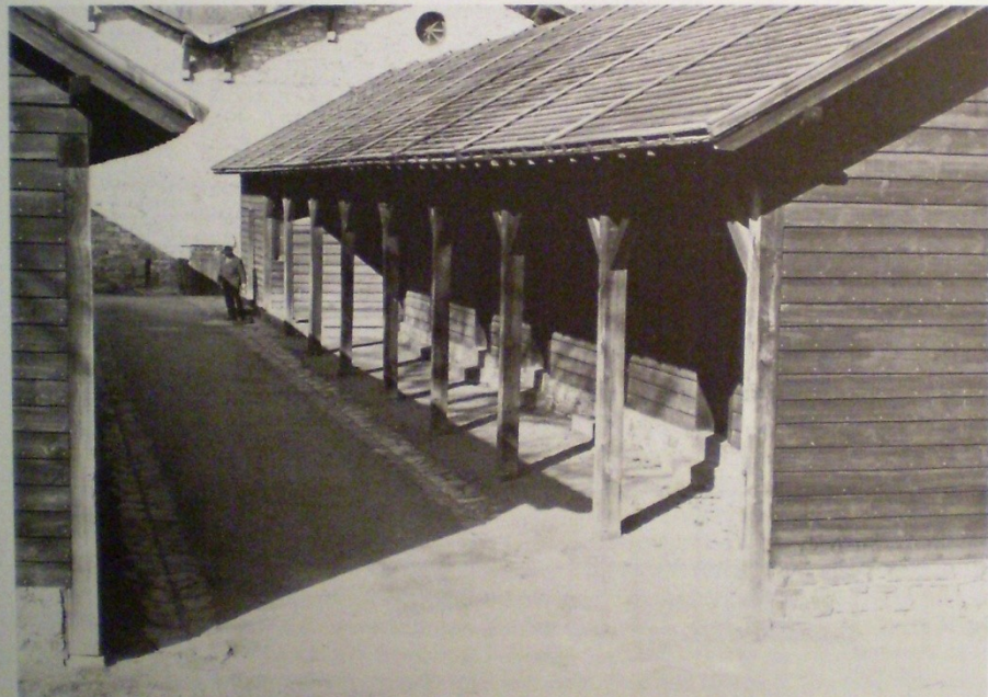
Abb. 128 Kastell Saalburg im Taunus (Hessen). Zwei rekonstruierte Mannschaftsbaracken (Centuriae), Holzbauten auf Steinfundamenten. Die Baracken sind nicht verputzt, sondern mit einer Bretterschalung versehen, nach Darstellungen auf der Trajanssäule. Bei der rechten Baracke ist das Vordach vor den Eingängen der Mannschaftsstuben deutlich zu erkennen. Am Ende dieser Baracke: vorspringender »Kopfbau« für den Centurio. Mit rund 35 m Länge gehören die rekonstruierten Baracken der Saalburg zu den kleinsten Bauwerken dieses Typs (Größe etwa wie in den Kastellen Hod Hill, Valkenburg, Hesselbach).
