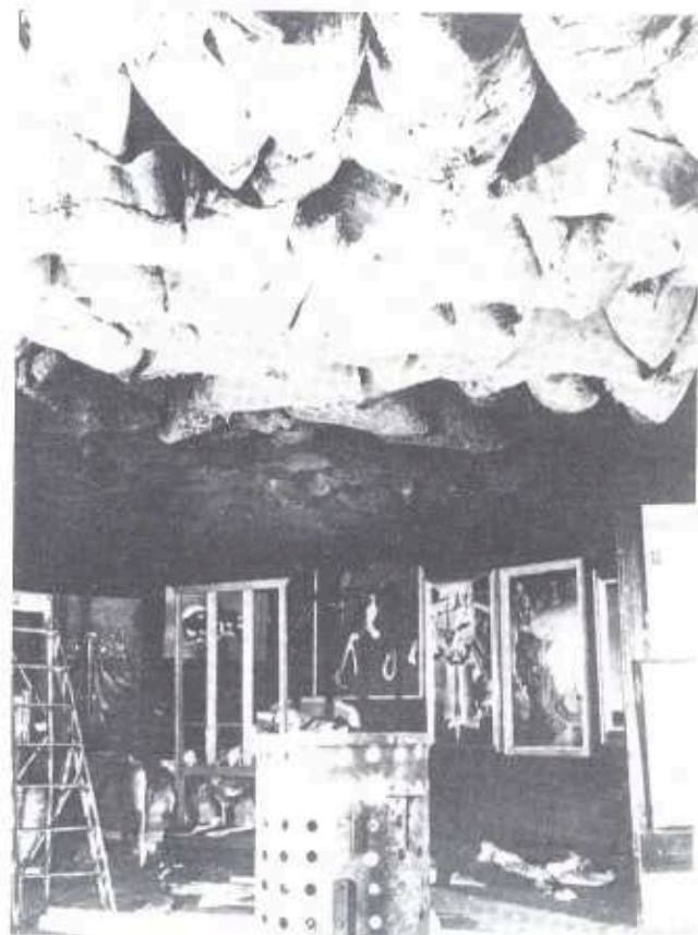
66. 1200 pytlů uhlí pověšených od stropu, leden 1938
