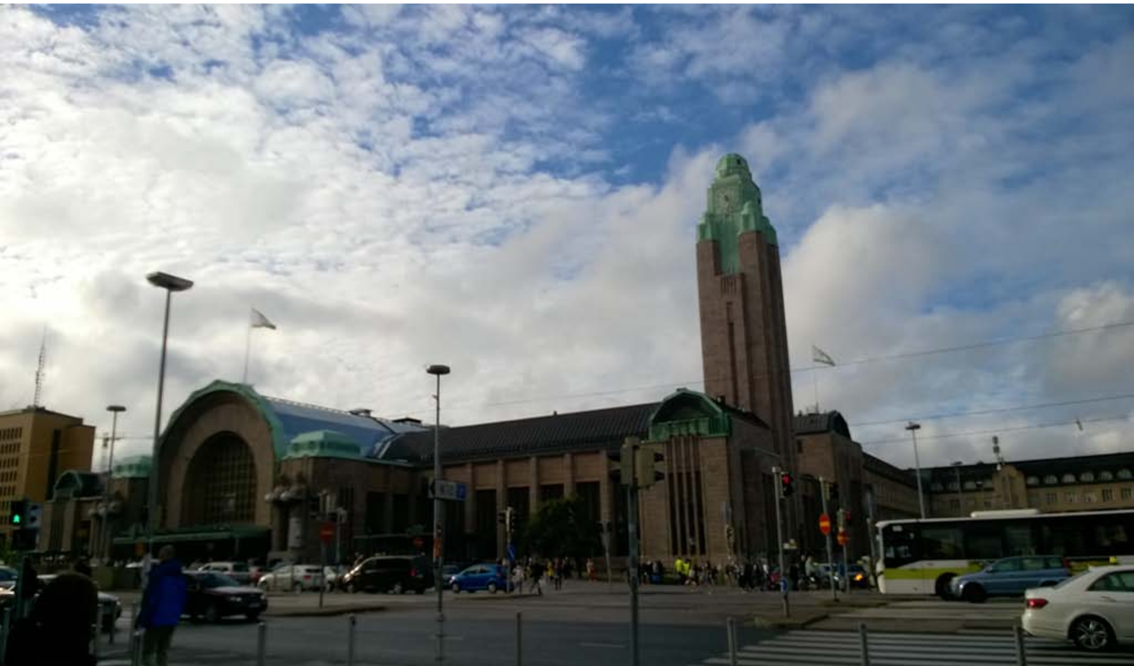
Budova hlavního nádraží v Helsinkách, Finsko (Eliel Saarinen, 1909-1919)
