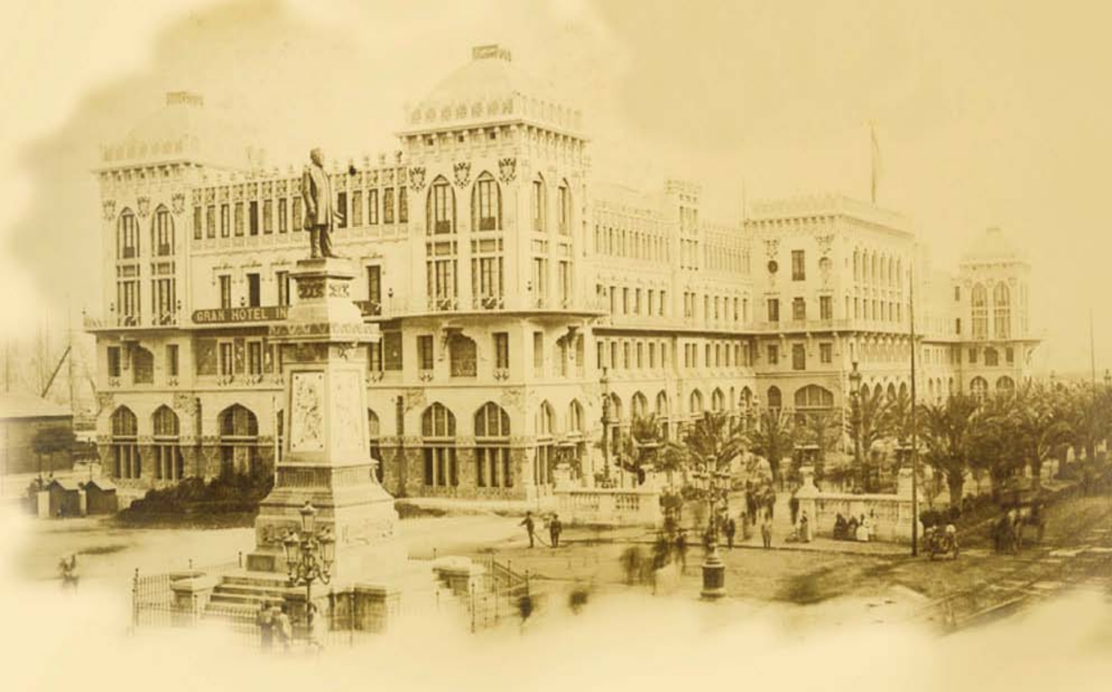
Hotel Internacional (1888): Budova speciálně vytvořena ku příležitosti Světové výstavy v Barceloně. Stavba o rozměrech 150x35 metrů, o výšce 4 poschodí a kapacitě pro 2000 hostů byla vybudována za rekordních 53 dní. Po výstavě ale musela být i přes protesty veřejnosti na jaře 1889 stržena.
