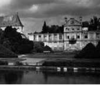
Park w Oliwie ze zniszczonym Pałacem Opatów
