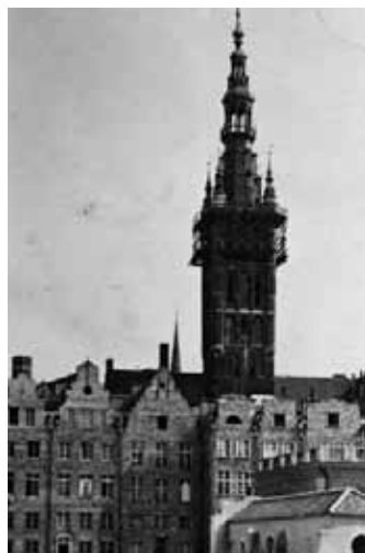
Odbudowa Ratusza Głównomijskiego w Gdańsku, ok. 1955 roku
