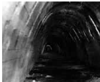
Wnętrze tunelu pod Biskupią Górką w Gdańsku
