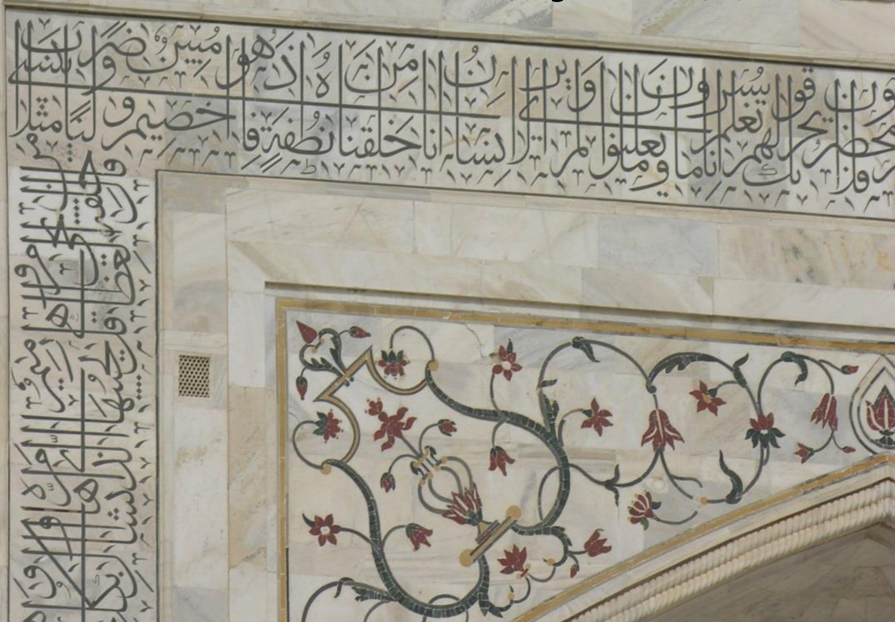
Verše K. na fasádě Tádž Mahalu, Agra (Indie), 17. stol.
