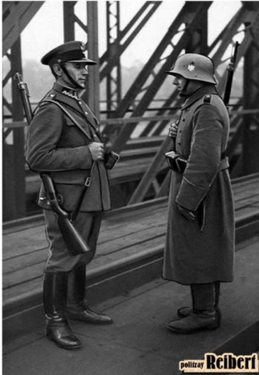
Obr. 20 Němci jsou na pěším mostě, který byl postaven na počest výročí císaře Františka Josefa.
