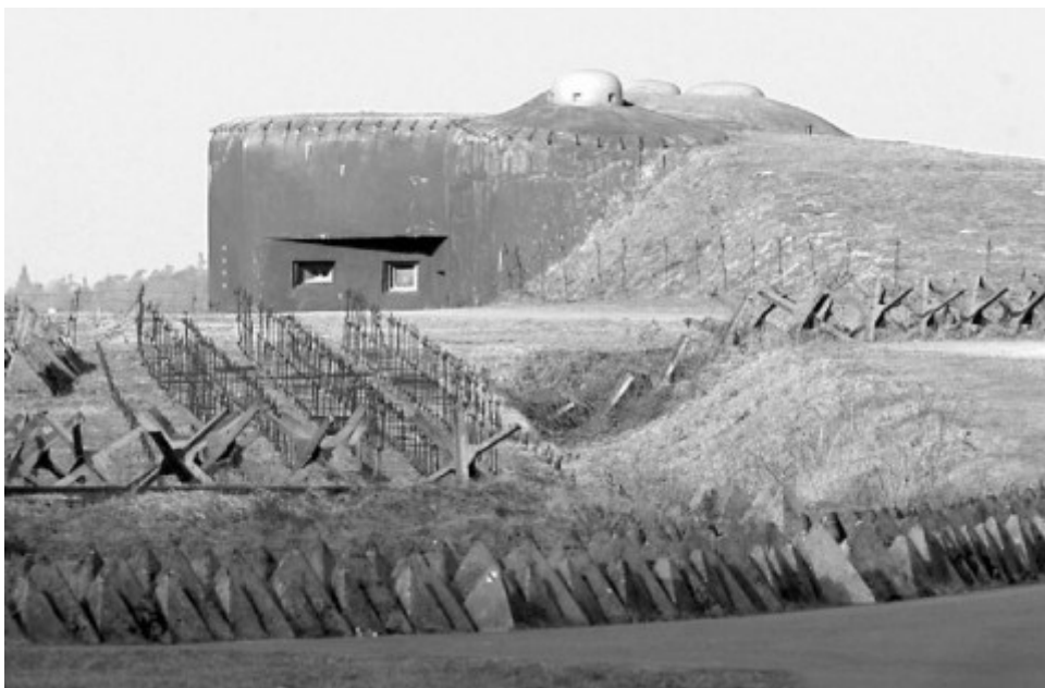
Obr. 14 Bunkr čs. pohraničního opevnění ("Benešova linie").
