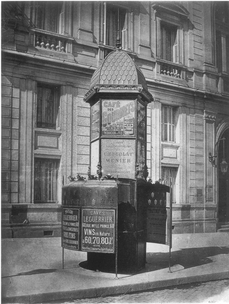
Fig. 1. Charles Marville: Pissotière in front of 44, rue de Rennes (later 4, place Saint-Germain-des-Prés), Paris, c.1865–1870. Bibliothèque Historique de la Ville de Paris, Paris.
