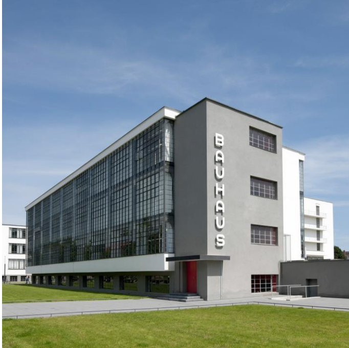
Architektura:Walter Gropius (1883-1969), Budovy školy v Dessau, 1925-26
