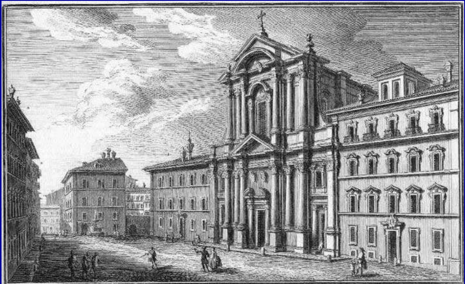
Chiesa di S. Maria in Campitelli 1. Casa de' Chierici Regolari della Madre di Dio, a. Palazzo del Sig. o Serbelli, Palazzo, Paulucci, e Caponecchi 2. Strada verso Piazza Montanara.
