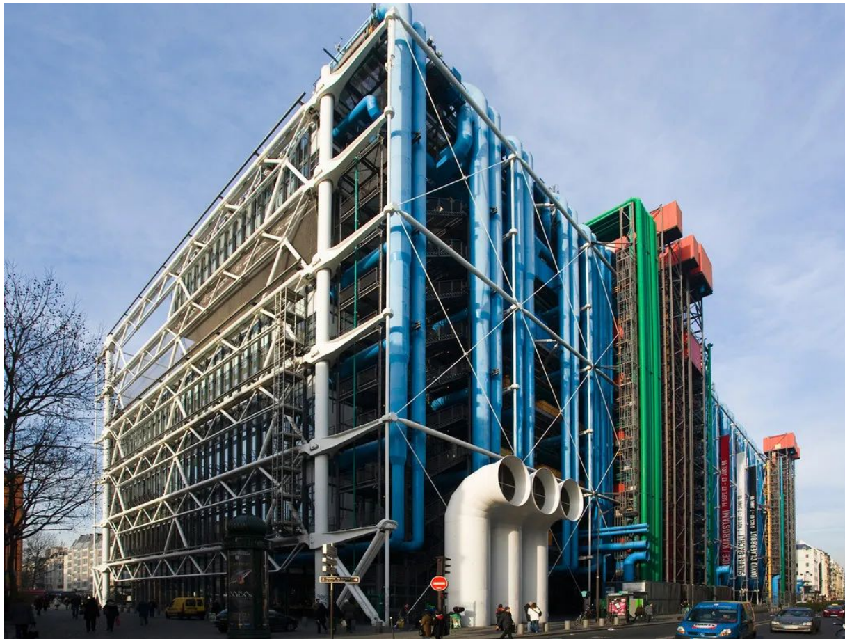
Potrubí jako provozně-mechanická, ale též estetická komponenta (Centre Pompidou; R. Rogers, R. Piano, 1977)
