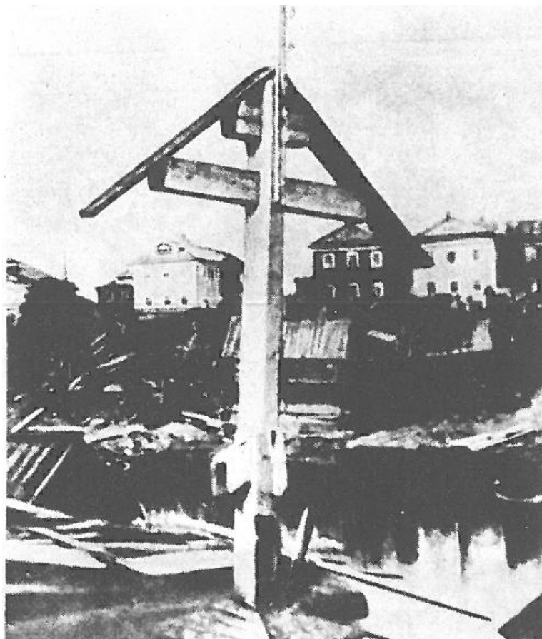
Elektrické vedení na kříži
