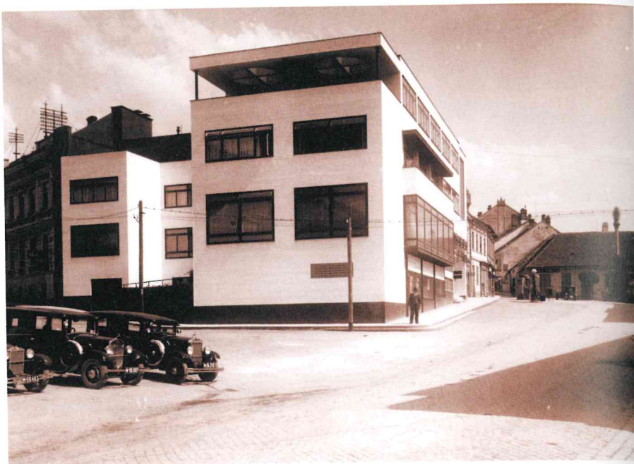
Bohuslav Fuchs — Jindřich Kumpošt, Městská spořitelna, Tišnov, 1931—1932
