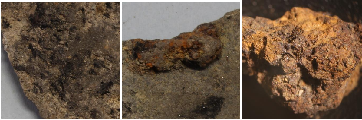
Obr. 11.02. Detaily znečištění povrchu uhlíky a železitou krustou. Na posledním snímku je detail železité krusty při zvětšení pod binokulární lupou.
