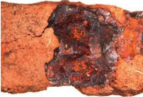
Aktivní koroze železa vlivem vysoké vlhkosti
