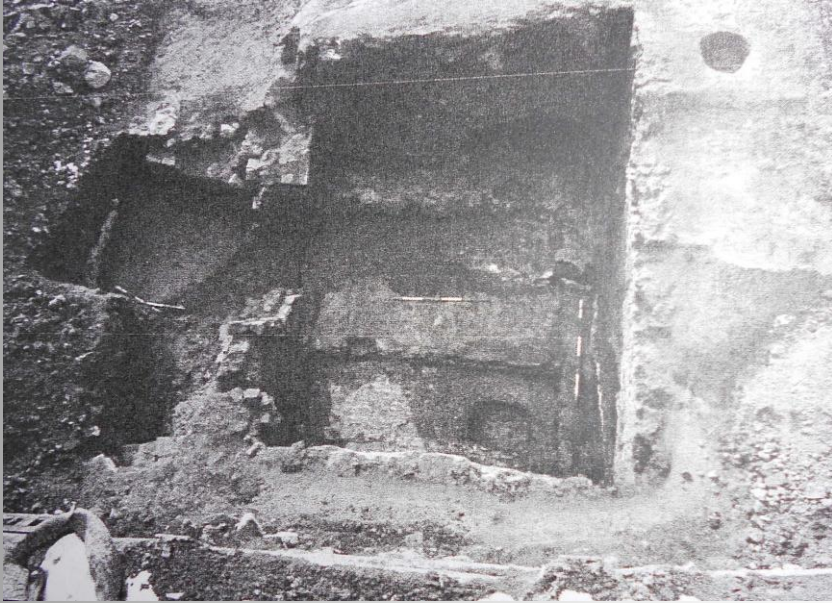
Komora cihlářské pece s tahovými kanály ve dně a částečně odkrytým předpecím
