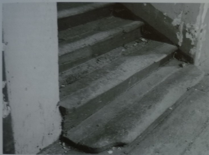
Běžné provedení stupňů renesančních schodišť z masivního dřeva, s vystupujícím profilem na čelní hraně, na zámku v Kuřívodch u Mimoně.
