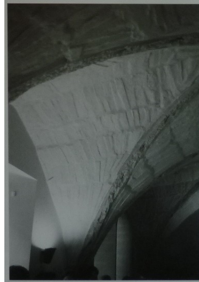
Otisky bednění, připraveného z úseků krátkých prken (možná šindelů), na kápičích křížových klenbách z 14. století – na fotografii z budovy pražského Karolina na Starém Městě, na kresbě z křížové chodby augustiniánského kláštera v Roudnici (J. Pešta).
