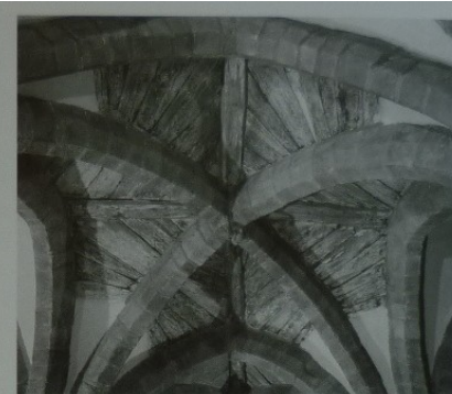
Dochovaný úsek bednění pod raně gotickými křížovými klenbami krypty pod bazilikou Nanebevzetí Panny Marie kláštera benediktinek v Třebíči z doby po polovině 13. století.
