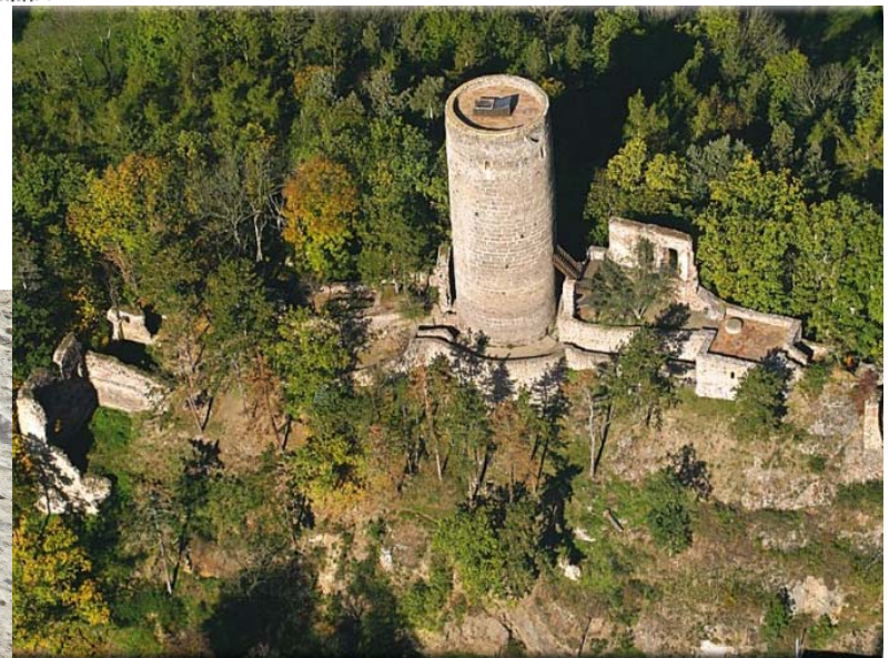
Žebrák 2.polovina 13.století Extremně úzké staveníště
