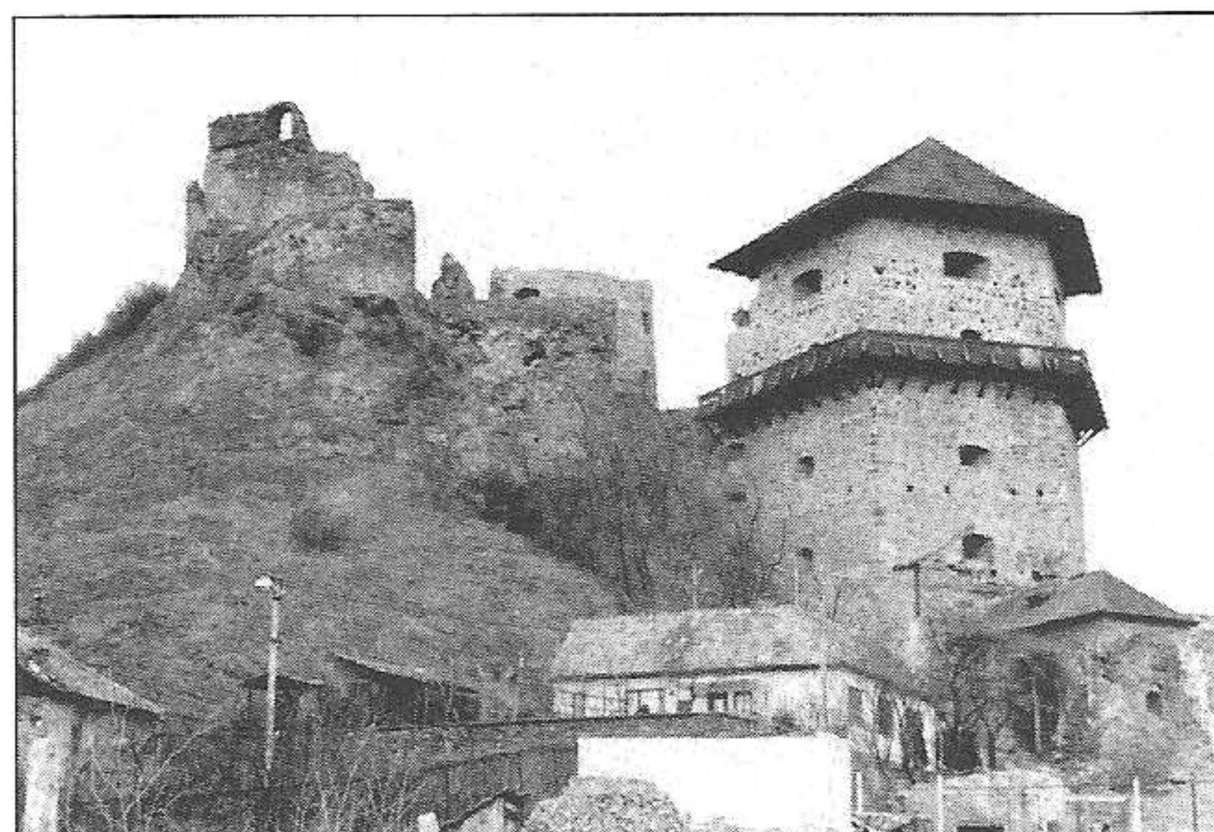
57. Filakovo – ukázkou renesanční bateriové věže na polygonálním půdorysu je tzv. Bebekova věž.
