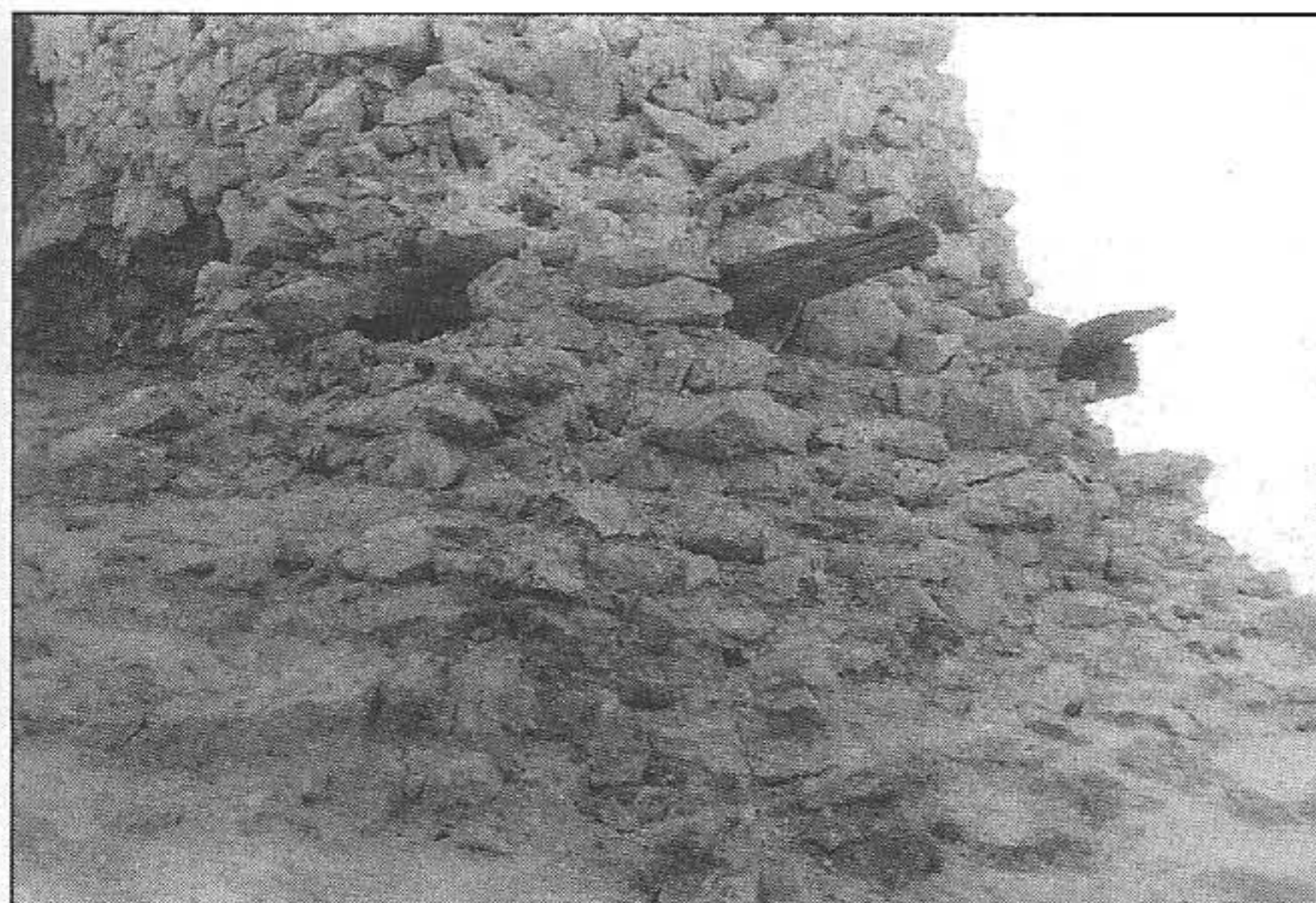
12. O technologii stavby vypovídá nález zpevňujících trámů (kleštin, něm. Balken) ve zdivu věže Tematína.
