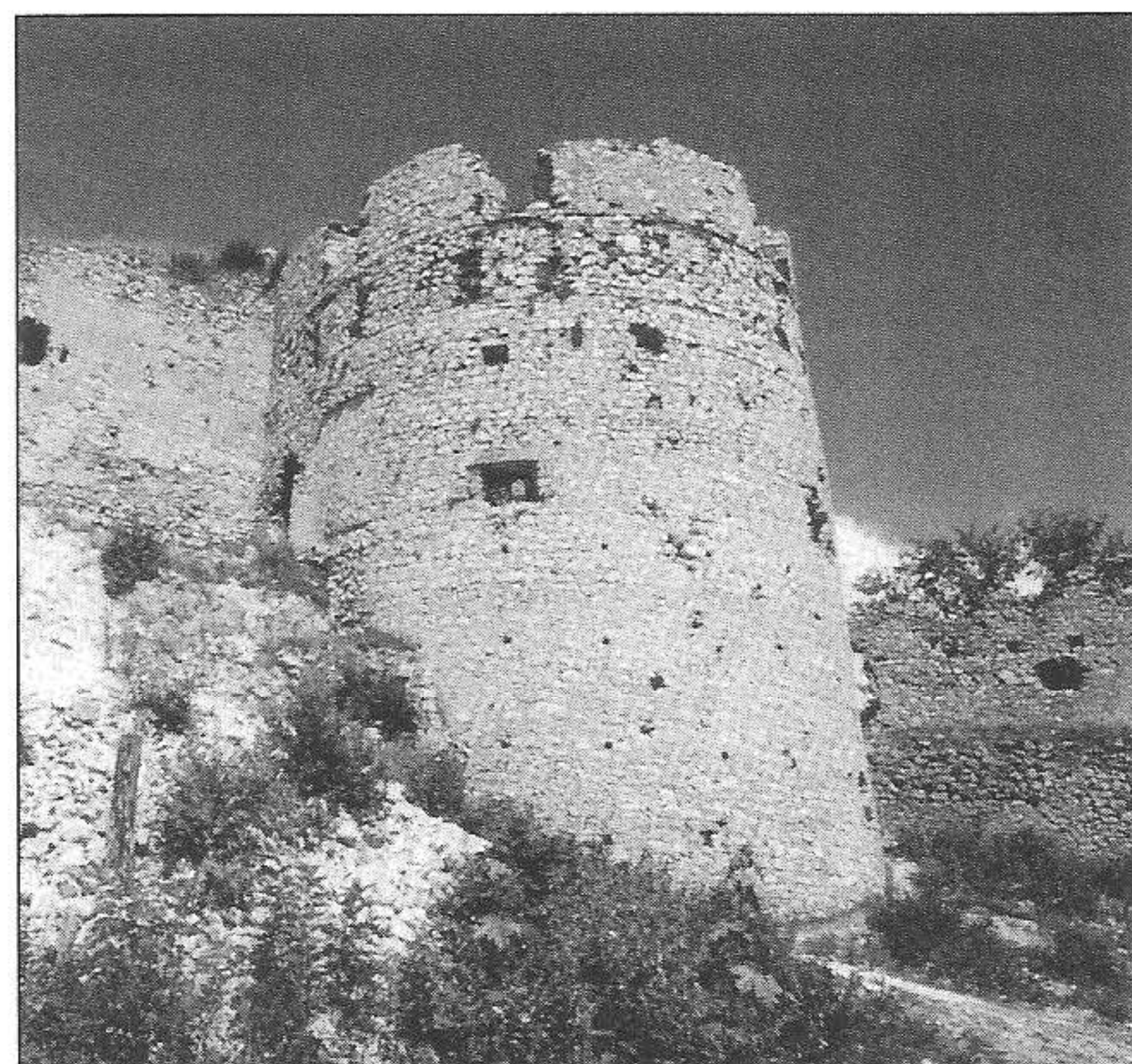
58. Plavecký hrad – raně renesanční dělovou baštu v jihovýchodním nároží horního hradu postavil podle dýmníků (otvor nad střelnou) odsávajících kouř výstřelu rod Fuggerovců.
