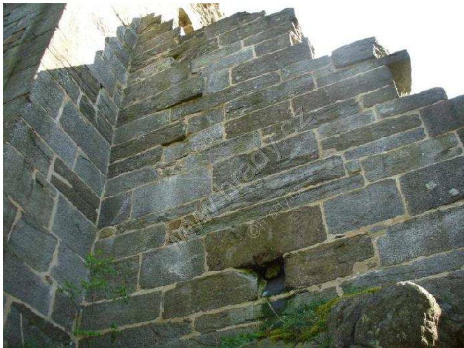
Vyústění prevétu ve zdivu
