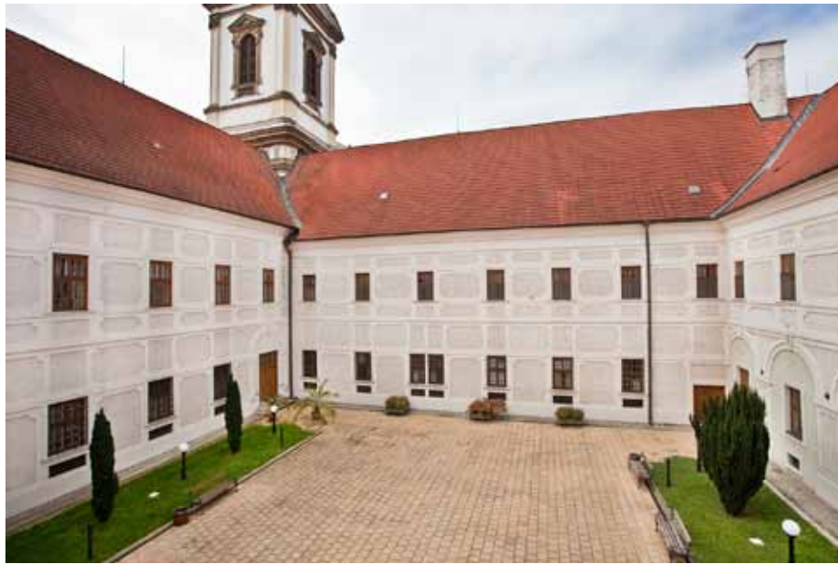
7 Klášter Hradisko, fasády druhého nádvoří, poslední čtvrtina 17. století.
