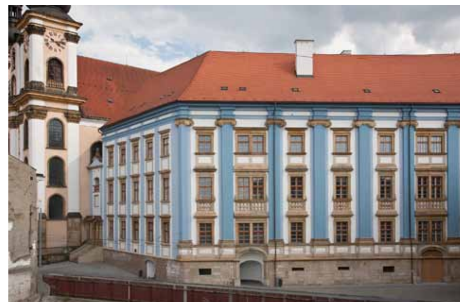
6 Nároží fasády školní budovy.
