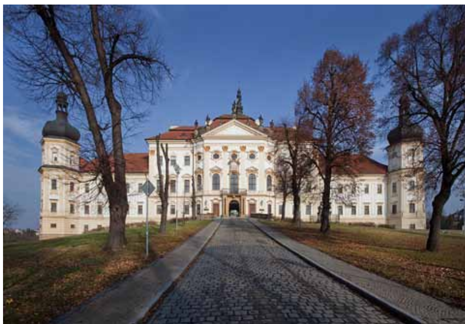
9 Pohled na hlavní průčelí kláštera Hradisko s prelaturou.
