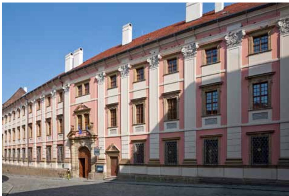
6 Průčelí tzv. Starého konviktu.
