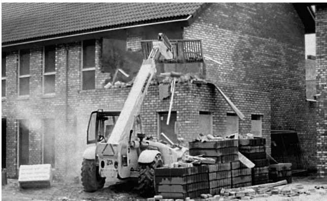
Figuur 4 Polonaise : Maciek vernielt zijn 'droomhuis' met een bulldozer
