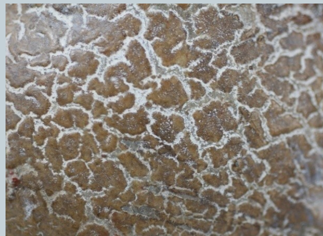
Krakely malby na dřevě vzniklé nesprávnou technologií malby, foto I. Fogaš
