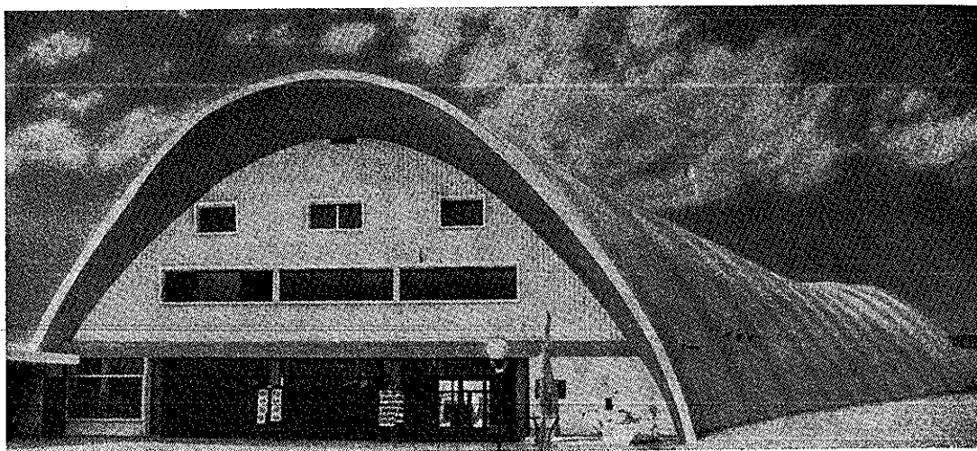
a) Celkový pohled na kino Salam v Agadiru (Maroko).—Osobitý architektonický výraz byl vytvořen ze snahy po atraktivnosti.
