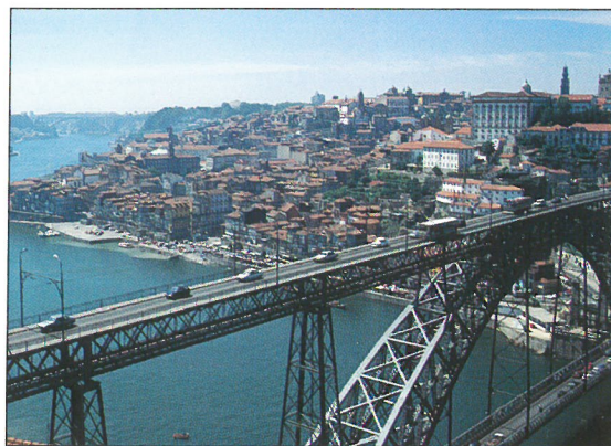
Ponte de D. Luís sobre o rio Douro (Porto).
