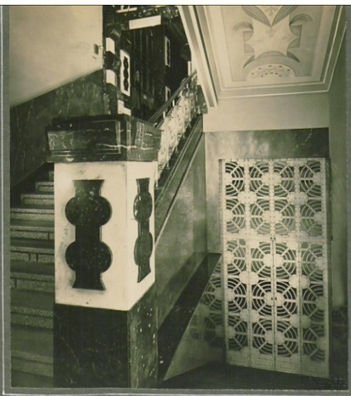
Mřížová vrata uzavírající místnosti depotní
