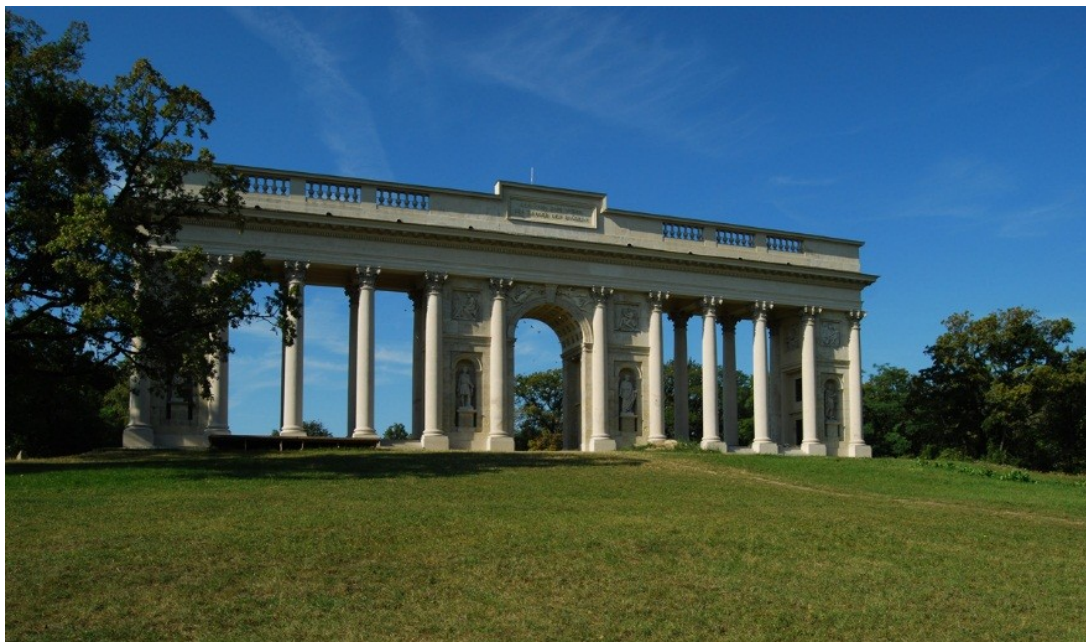
Apollonův chrám, 1817-19, arch. Josef Kornhäusel, dokončení J. F. Engel
