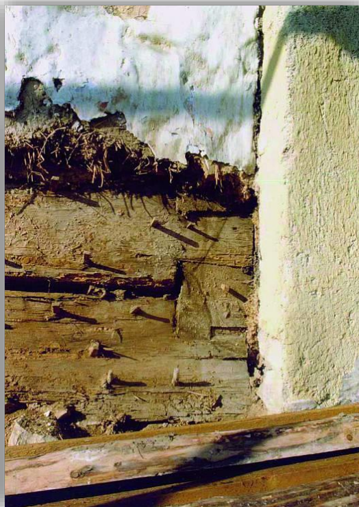
Hořovice (okres Beroun), Palackého nám. čp. 253. Na blavním průčelí bývalého hospícu kajetánů ze 17. stol. byl odbalen pozůstatek srubové komory, zachované i s jejím povalovým stropem (řada čel trámů) a mladší roubenou „nadezdívkou“ (foto V. Jesenský).
