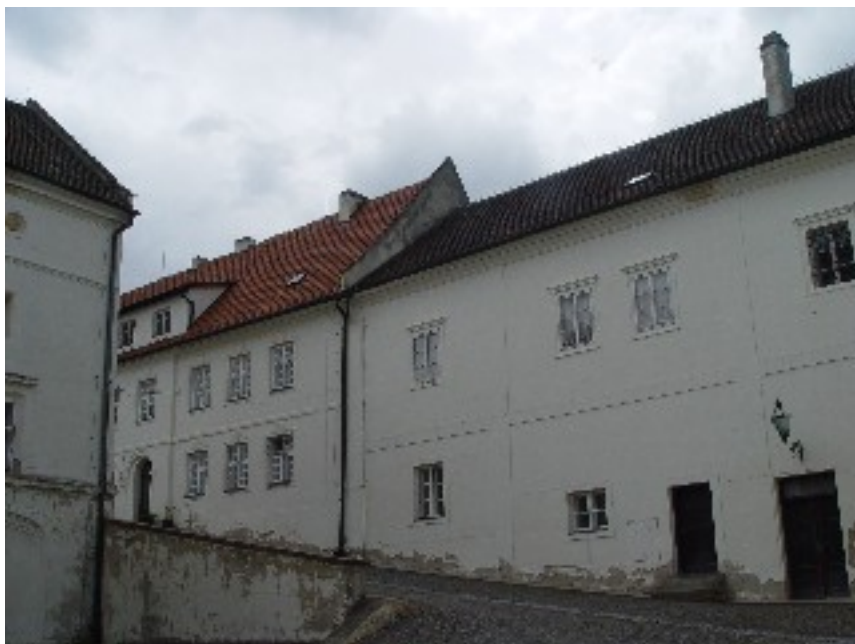
SZ Kunštát – Dolní zámek (projekt centrálního depozitáře NPÚ ?)
