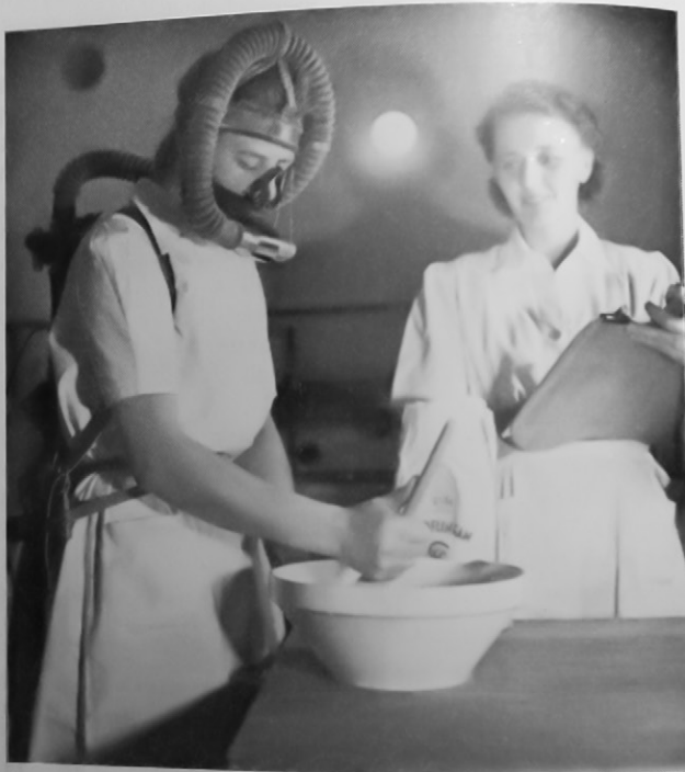
Fig. 5. Mätning av energiomsättningen vid tillsättning av deg på olika arbetshöjder medelst Douglas' metod. Genom analys av utandningsluften, som uppsamlas i en säck, beräknas energiomsättningen hos den arbetande.
