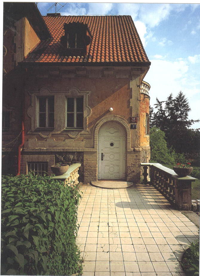
Pavel Janák, Hořovského vila v Praze, ulice Na lysinách, < schodišťová hala a vstup. 1921-1922
