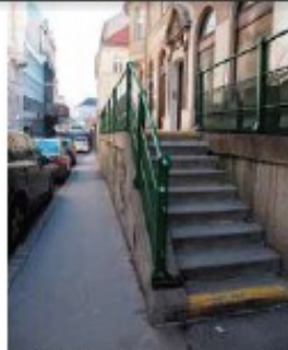
5 Doplňkový chodník na úrovni pod schodištěm v Joandlitzgasse; foto: Janica Šipulová.
