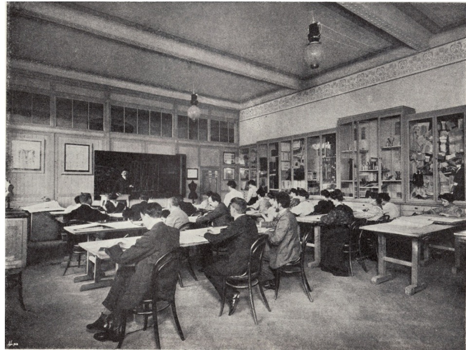
Unterrichtssaal des Erzherzog Rainer-Museums
