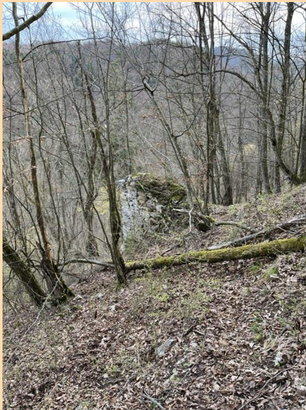
Vlastní foto křídlové zdi
