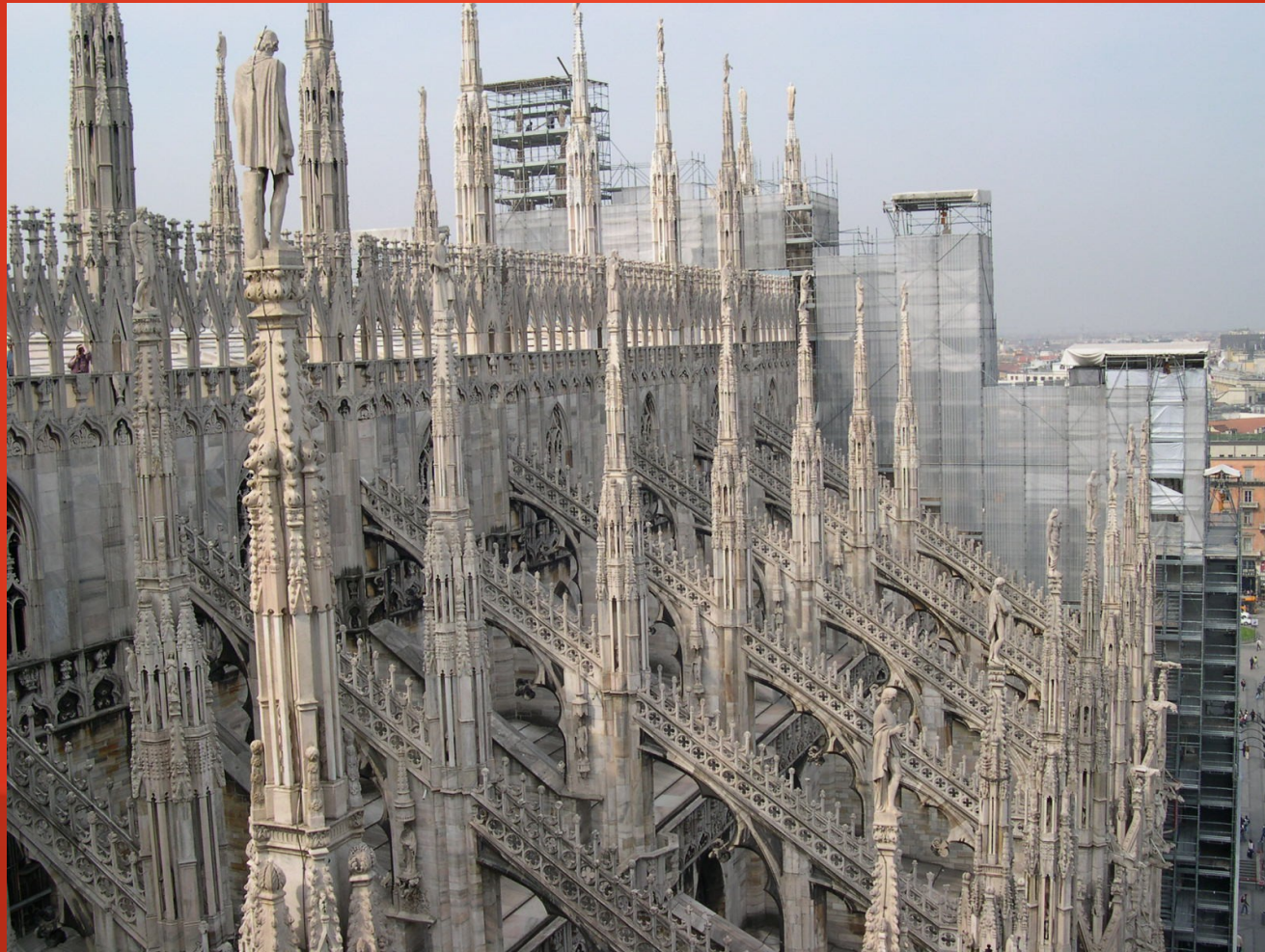
Vnější opěrný systém dómu v Miláně
