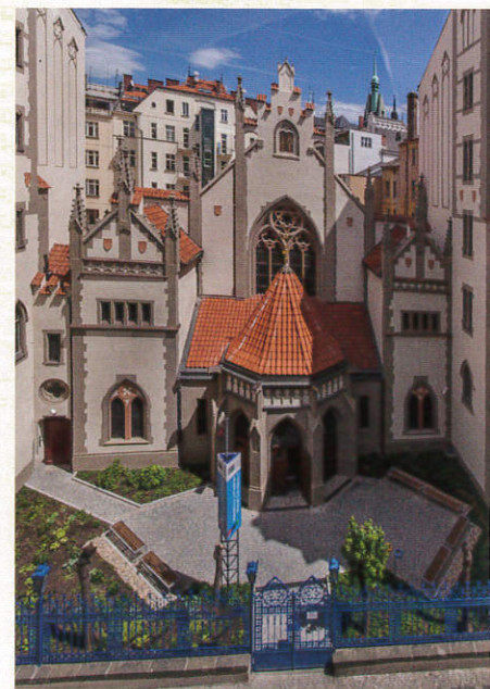
Průčelí Maiselovy synagogy po obnově, 2015
