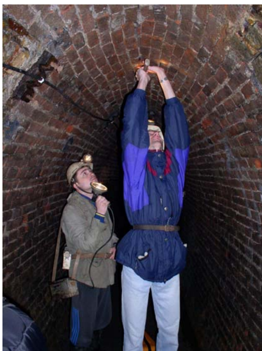
Obr. 5 Zatlučení měřičských hřebů do stropu štolý.
