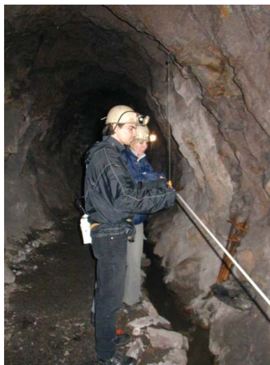
Obr. 5 Zatlučení měřičských hřebů do stropu štolý.
