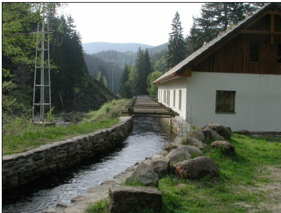
Foto 2 Antropogenně upravené koryto Březového potoka, tzv. geometrický profil. Březový potok byl upraven téměř v jeho celé délce, v určitých oblastech došlo k překladům koryt (Foto: M. Matoušková)
