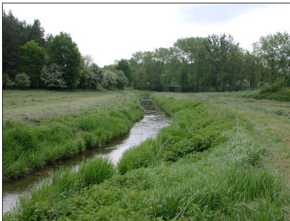
Foto 2 Antropogenně upravené koryto Březového potoka, tzv. geometrický profil. Březový potok byl upraven téměř v jeho celé délce, v určitých oblastech došlo k překladům koryt (Foto: M. Matoušková)
