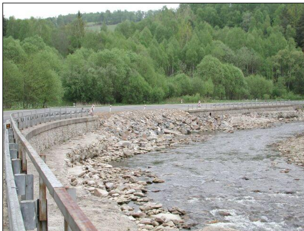
Foto 4 Porušení zpevněného břehu Otavy pod Annínem při povodni 2002 (Foto: M. Matoušková)
