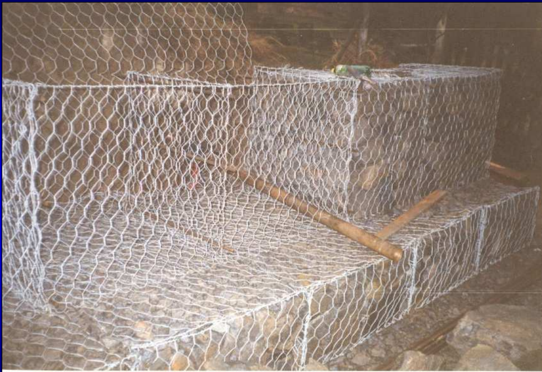
Gabionová opěrná zeď - Vsetín Jasénka (Maršálek 2003)
