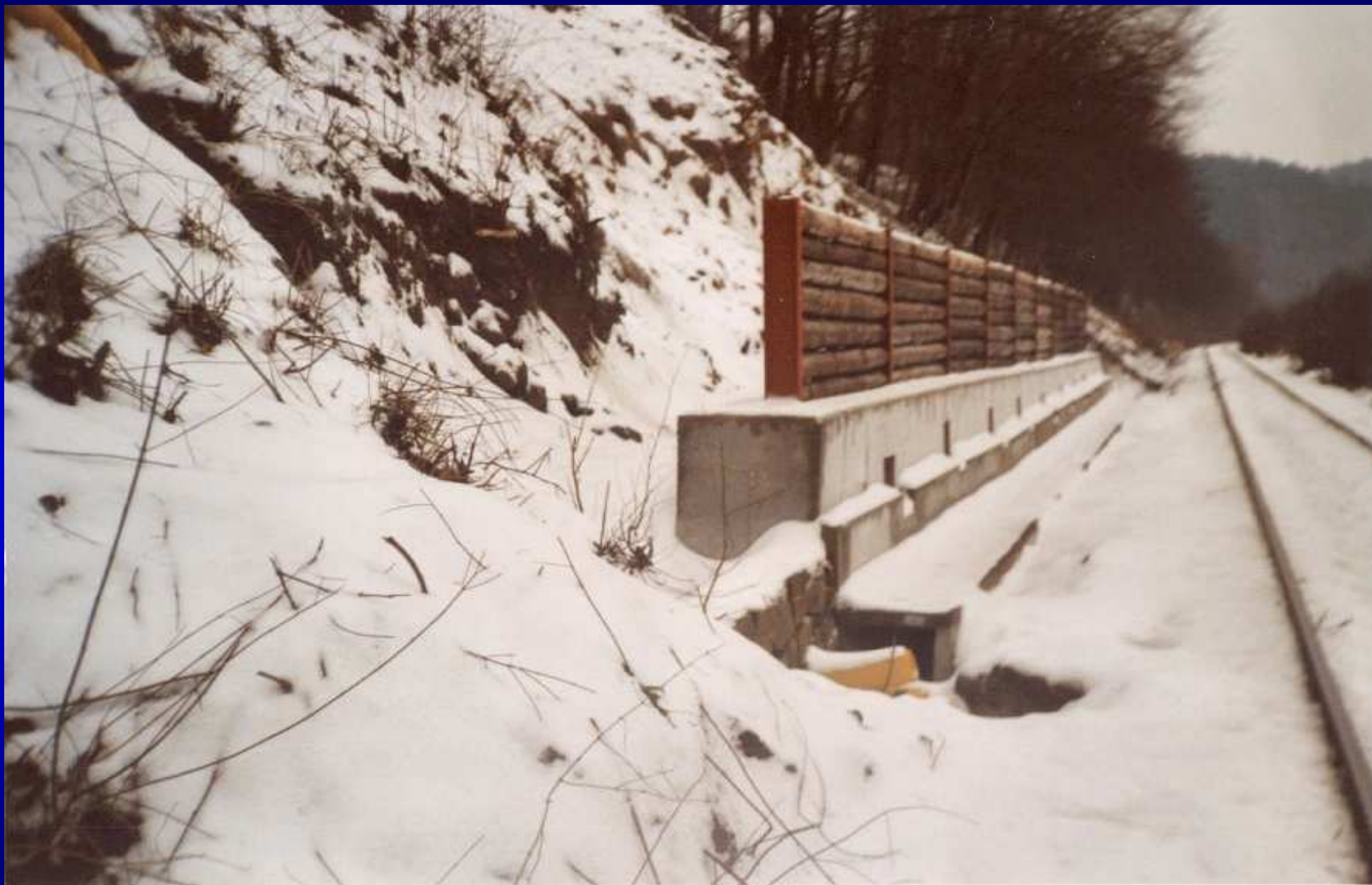
Zárubní zed' - Ústí u Vsetína (Maršálek 2003)
