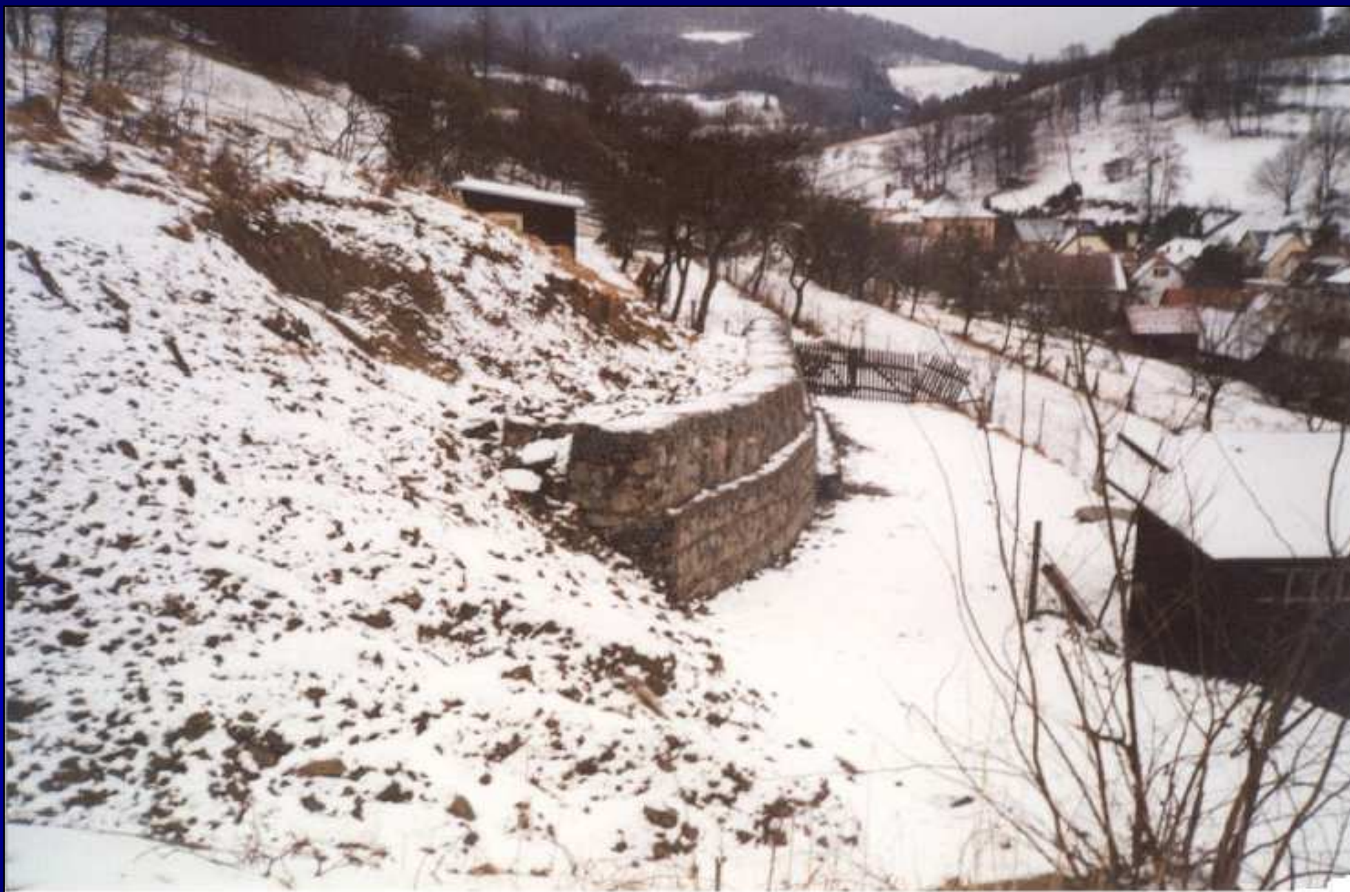
Gabionová opěrná zed' - Vsetín Jasénka (Maršálek 2003)
