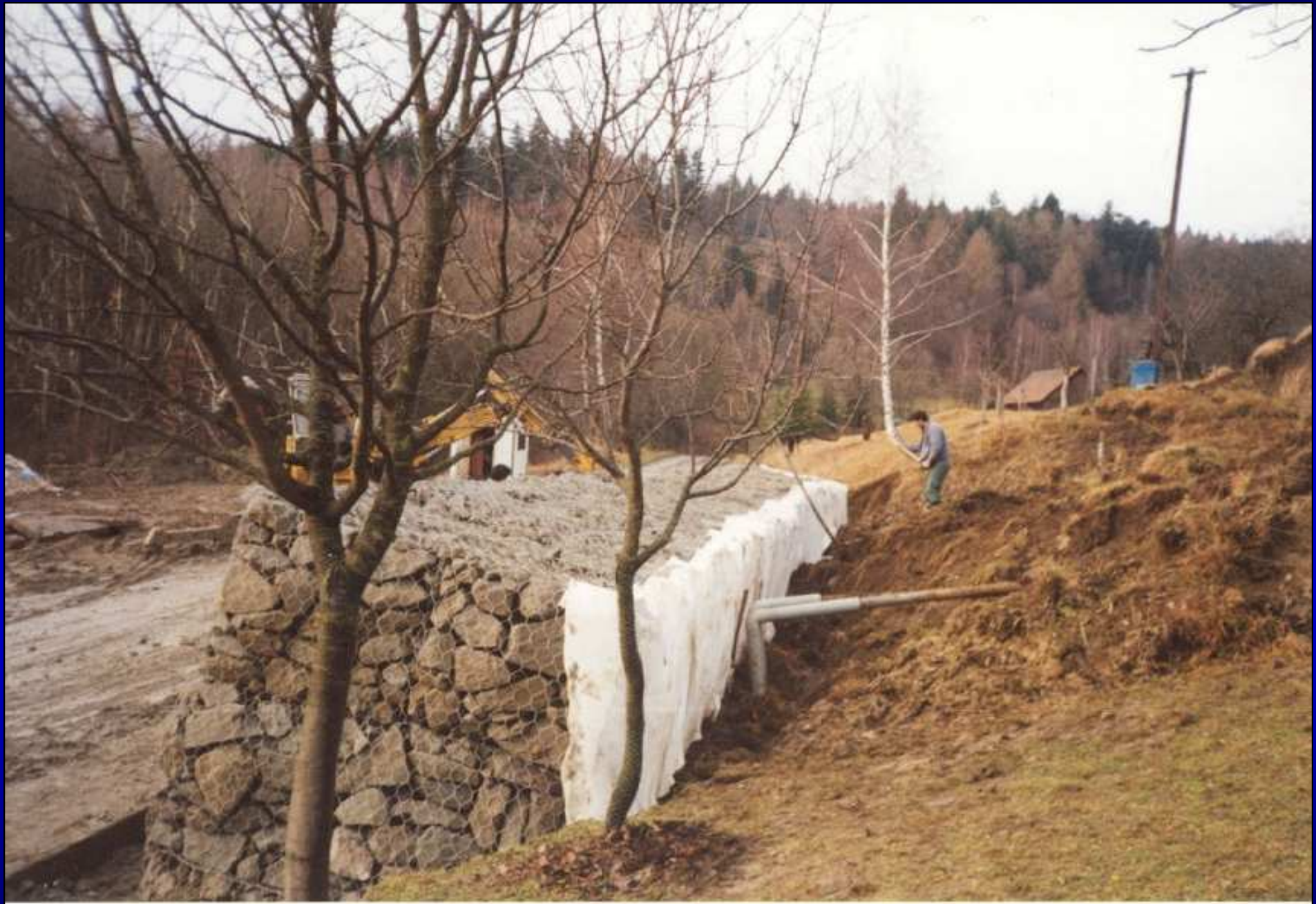
Gabionová opěrná zeď - Lidečko Račné (Maršálek 2003)
