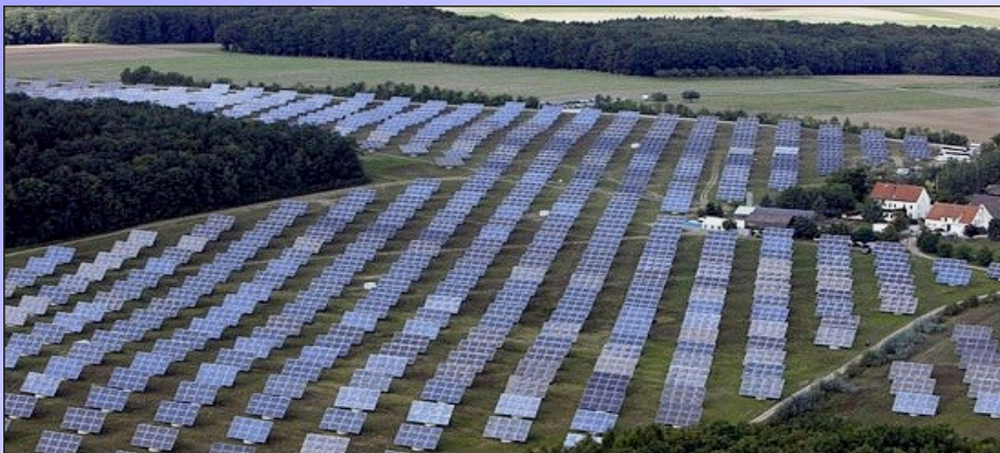
elektrárna využívající solární panely (Bavorsko)
