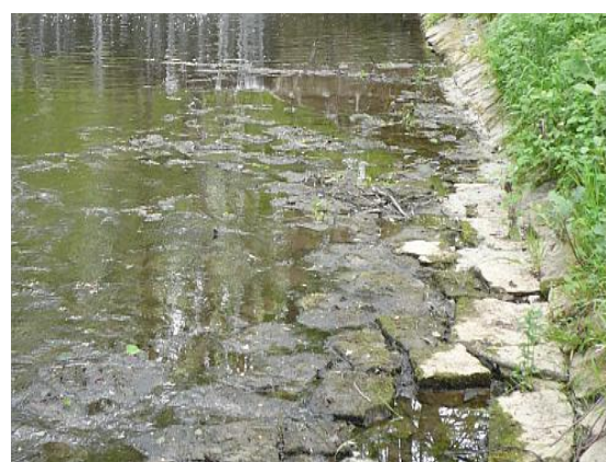
Zpevnění dna kamennou dlažbou.
