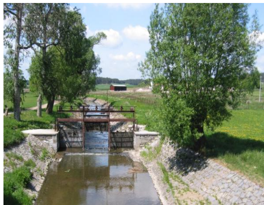
P břeh - jednotlivé stromy, L břeh – přer. pásy vegetace
