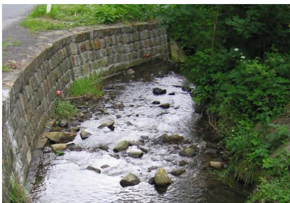
Zpevnění břehu kamennou dlažbou
