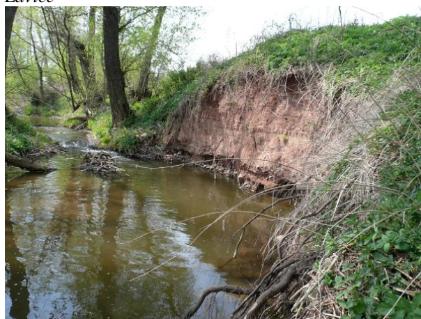
Tůň v úseku s výraznou boční břehovou erozí
