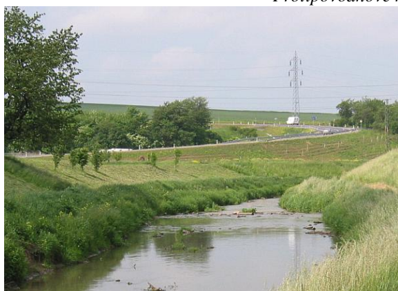
Liniové stavby vedené paralelně s korytem – násep silnice
