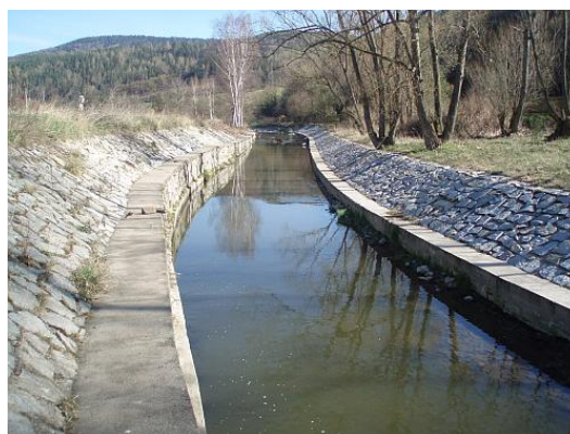
Souvislá úprava profilu - zpevnění břehu i dna betonovými deskami (vlevo), kam.dlažbou (vpravo)
