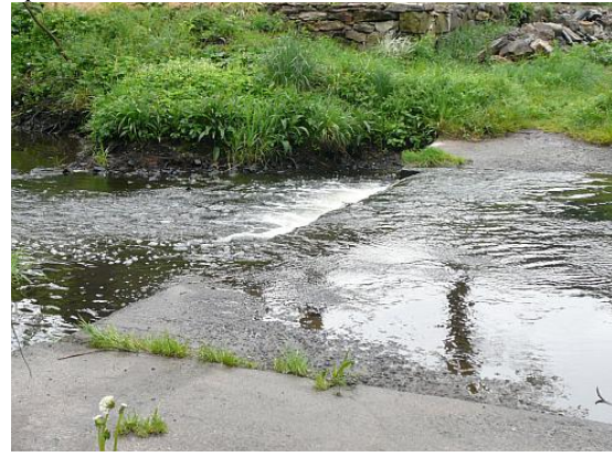
Zpevnění dna betonem – betonové desky
