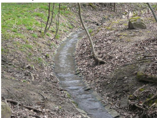
Zpevnění dna betonem – prefabrikované profily
