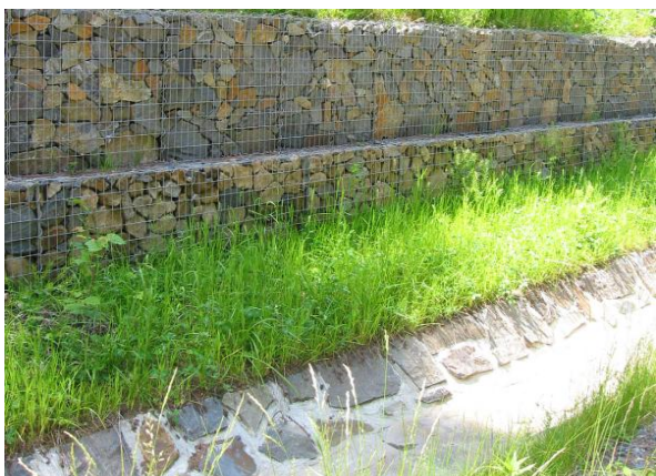
Gabiony na břehu koryta, koryto zpevněno kam.dlažbou
