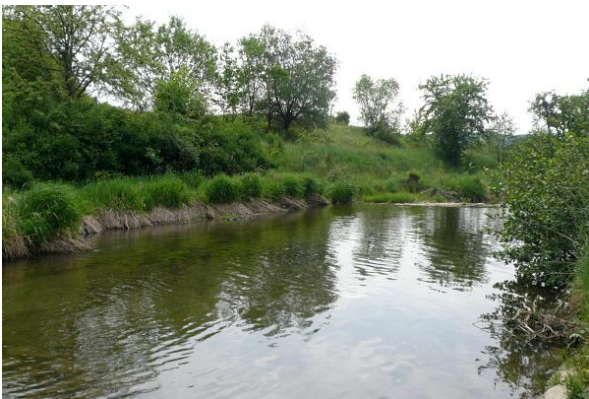
Vzdutí na malém toku nad nízkým stupněm
