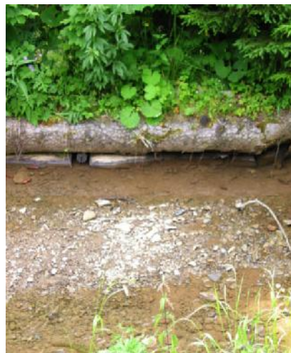
Vegetační opevnění břehu kulatinou
