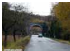
Nadjezd 1435 mm vlečky přes silnici Prosetín - Skuteč
