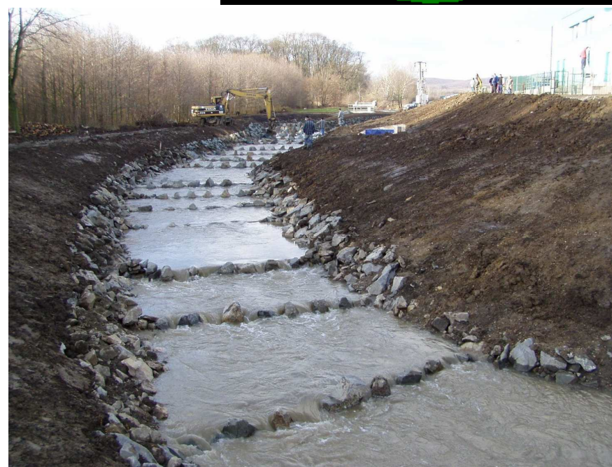
Rybí přechod na Dyji u Bulhar
