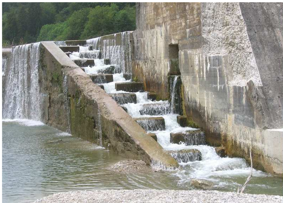
Rybí přechod na řece Isar, Německo
