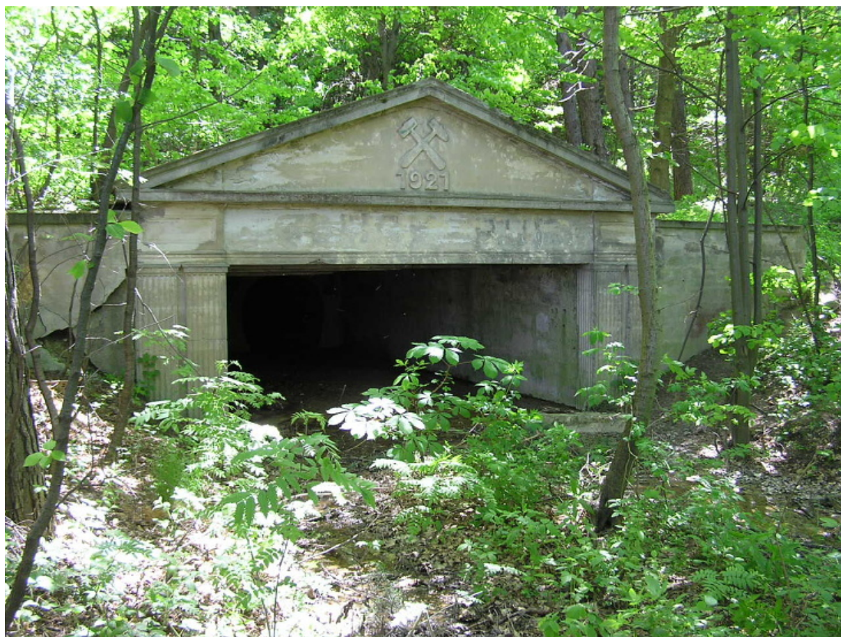
Portál štoly na kaolínovém ložisku Vidnava.
