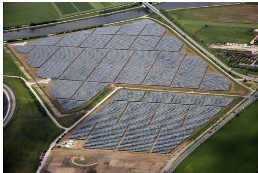
Serpa, Portugalsko 11 MW Fotovoltaické panely
