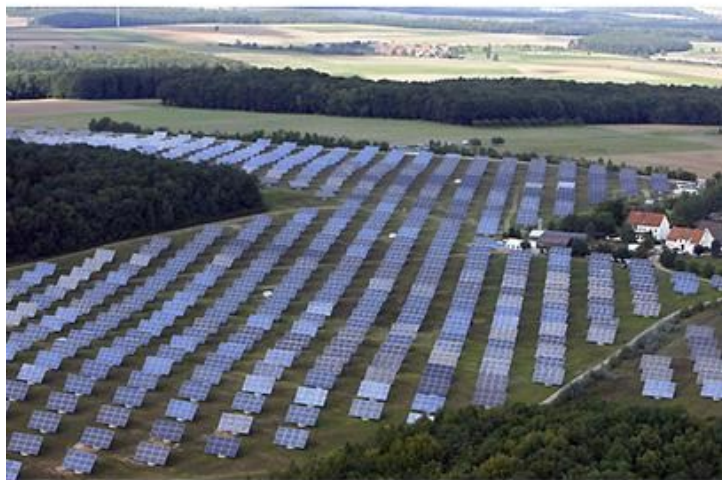
Gut Erlasee Solar Park 12 MW Fotovoltaické panely
