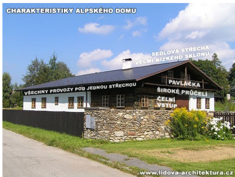
Obr. 5 Foto Alpského domu s popisem jeho částí (převzato z www.lidova-architektura.cz )
