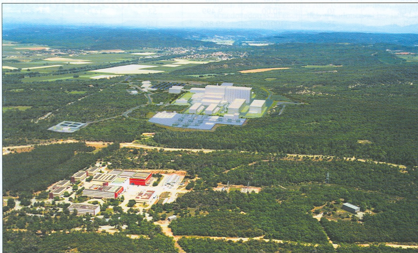
Foto 8.3 TOKAMAK – příprava lidstva na energetické využívání termonukleární syntézy, pohled na budoucí umístění TOKAMAKu 500 MW v Cadarache, Francie
