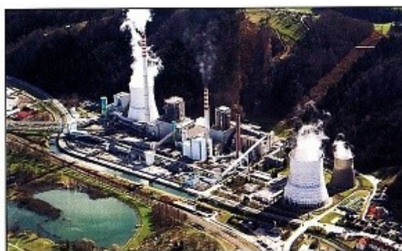
Obr. 22 Tepelná elektrárna Šostanj
