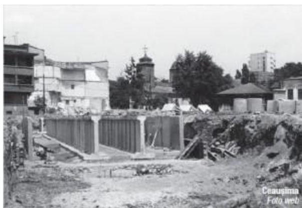
Obr.50 Stavba Lidového paláce (Bukurešť)
